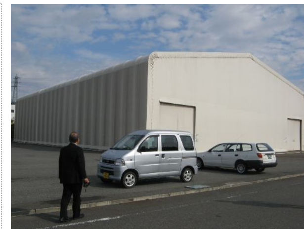
四之宮にある「相模川流域右岸処理場」に設置されたドーム型の大型倉庫
