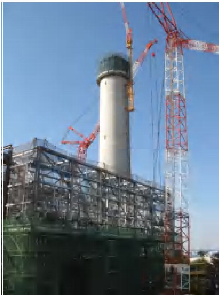
今年10月に稼働予定の「次期環境事業センター」
